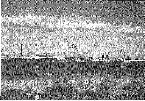
(長島町) 河口堰工事
